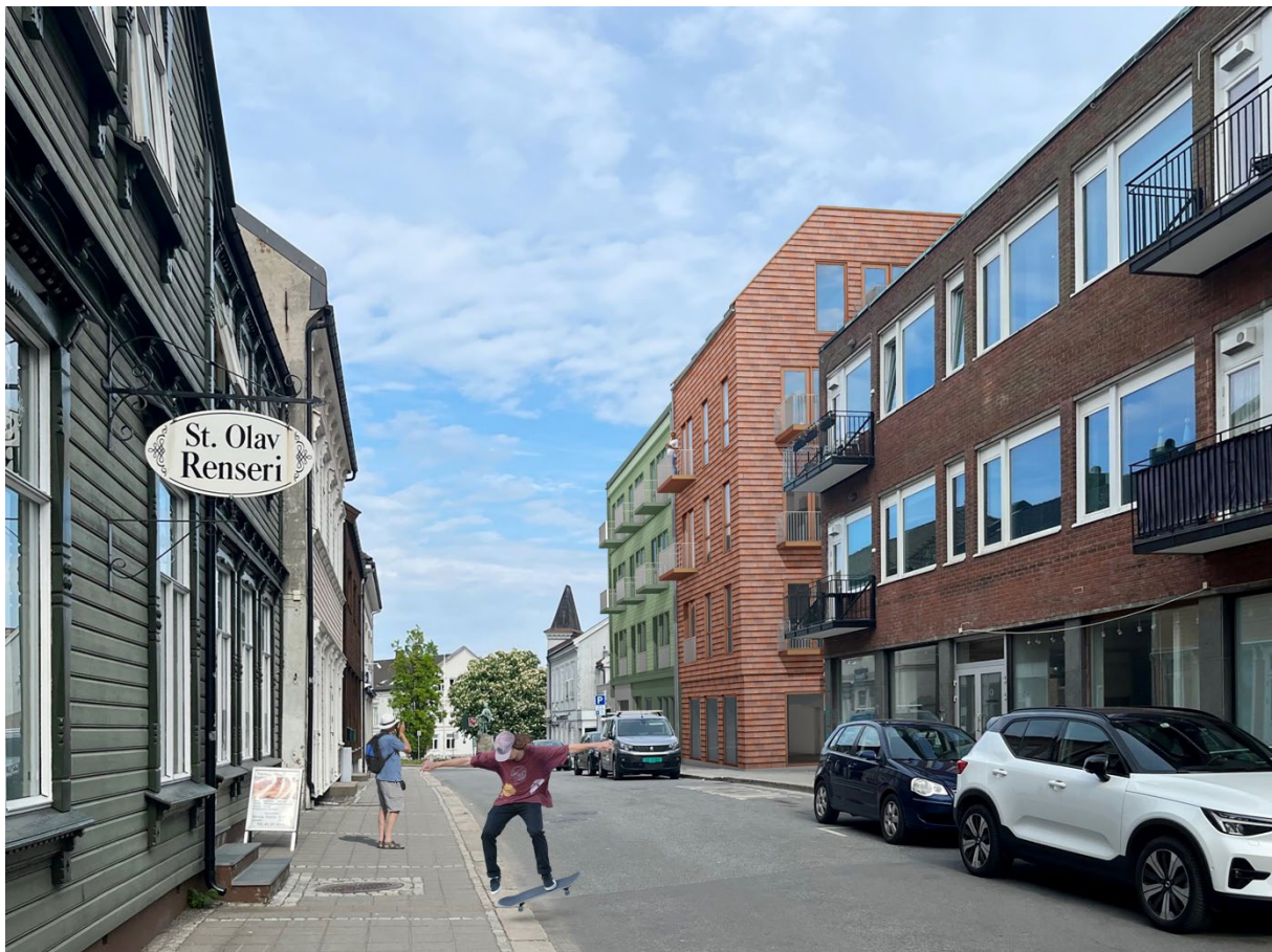
Prosjektet sett fra Torggata mot nordøst
