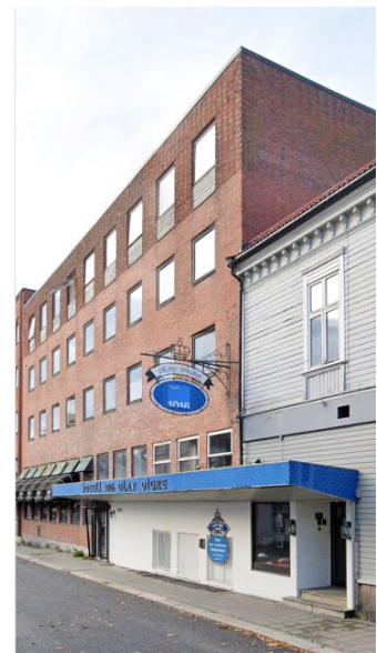
Glengsgata 21, nyere del
