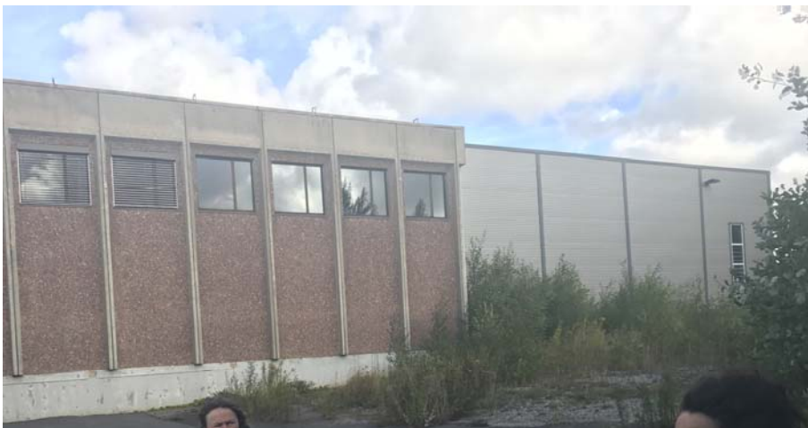
Bilde 3: Lagerbygg med tilbygg mot øst
