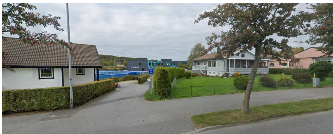
Figur 10 Eksisterende bebyggelse sett fra Ludvig Enges vei. Planområdet ligger bak eneboliger og minilager (blå bygg). (Skjermdump Google Streetview. Image capture 2019)
