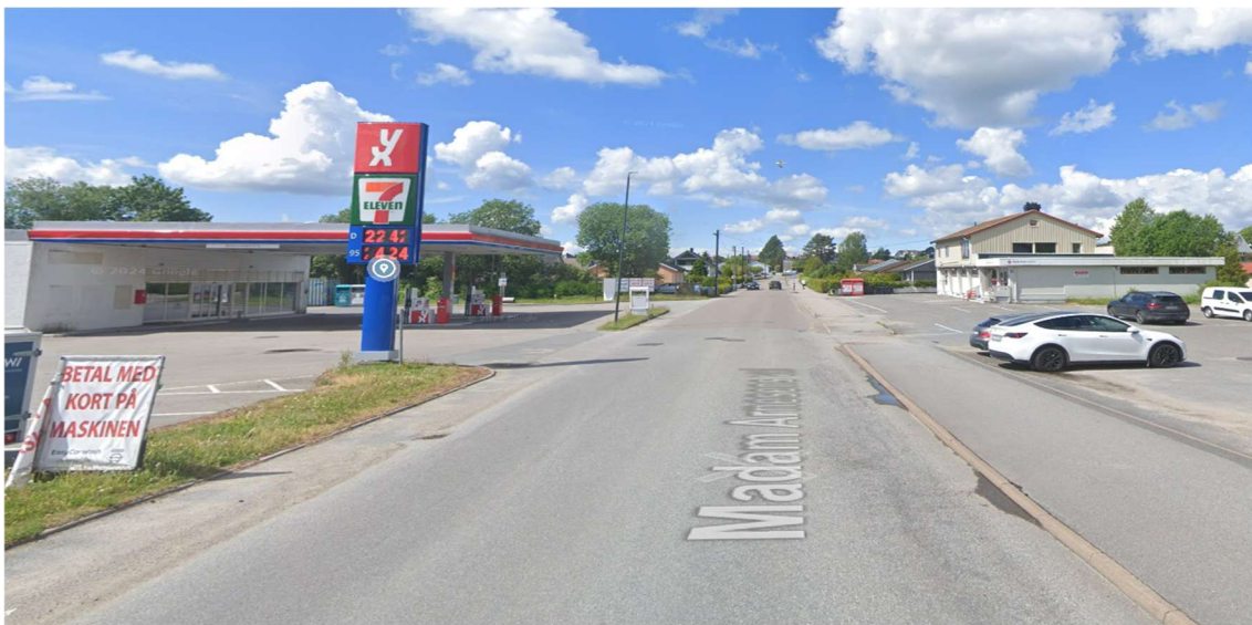
Figur 7 Ensidig fortau på nordsiden av veien i retning Tunevannet (bilde fra Google Streetview 2024)
