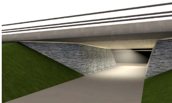
Figur 7-3: Undergang med skrå avslutning og vegger gir godt lys og luftighet
