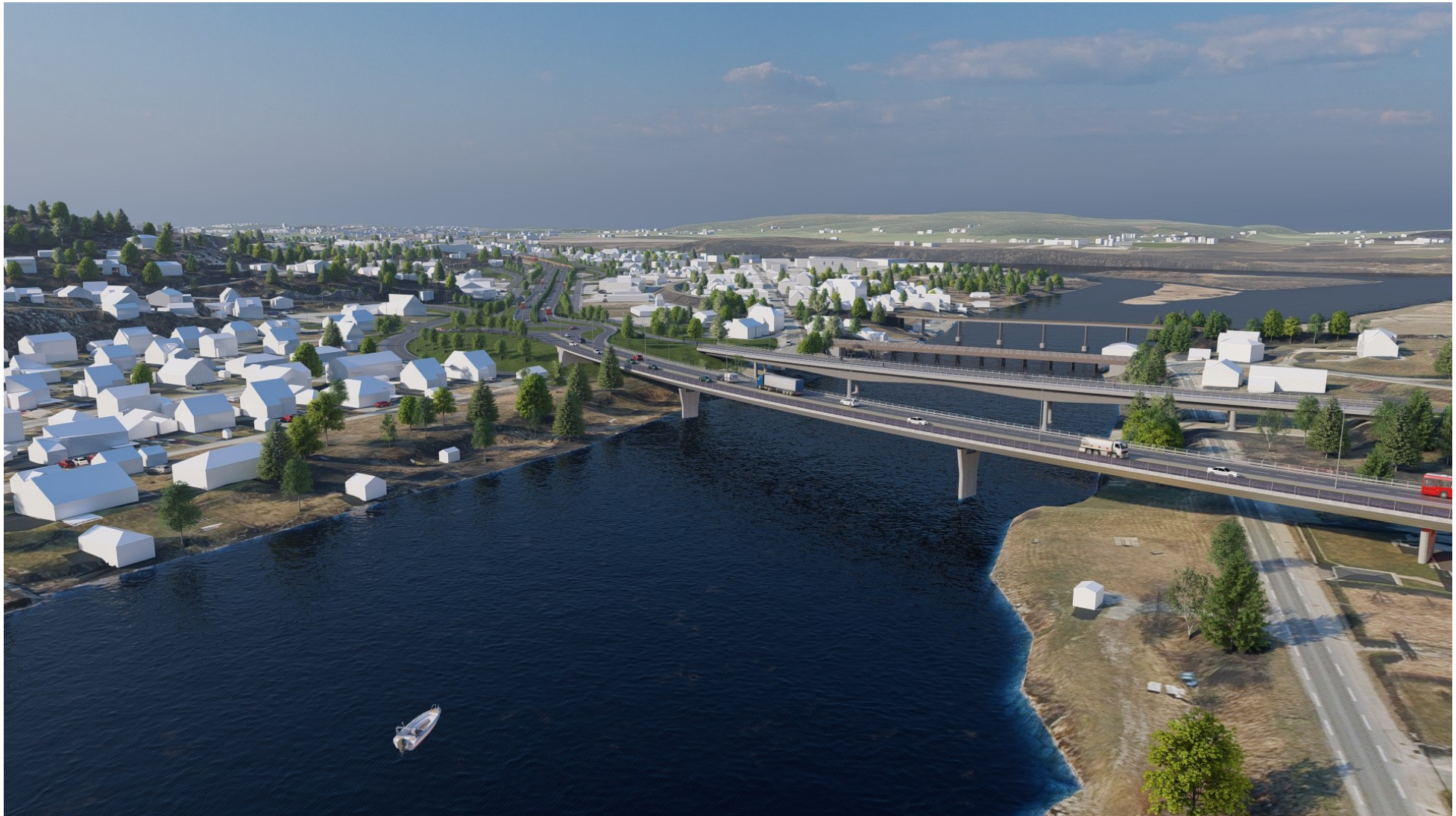
Figur 6-6: Rolvsøysund med ny kjørebru til venstre. Dagens kjørebru midt i bildet blir bru for sykkelveg med fortau
