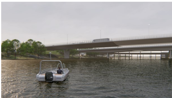
Figur 0-11: Mange bruer ved siden av hverandre over Rolvsøysund. Den nye kjørebrua sett fra nord.
