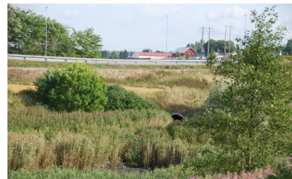
Figur 8-8: Veganlegget kommer litt nærmere Alvimdammen, og dammen vil bli brukt som resipient
