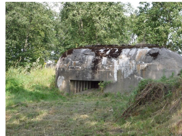
Figur 8-10: Bunker/skytestilling tilknyttet Greåker fort på østsiden av Rolvøysund
