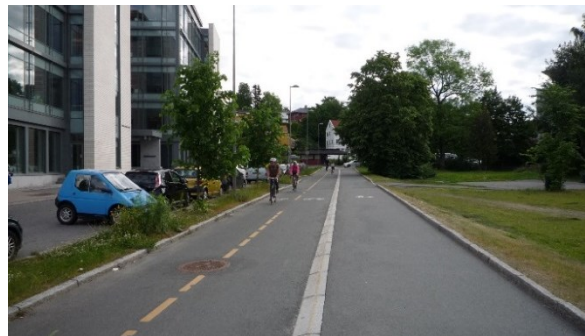
Figur 0-3: Sykkelveg med fortau skiller gående og syklende. Skøyen, Oslo
