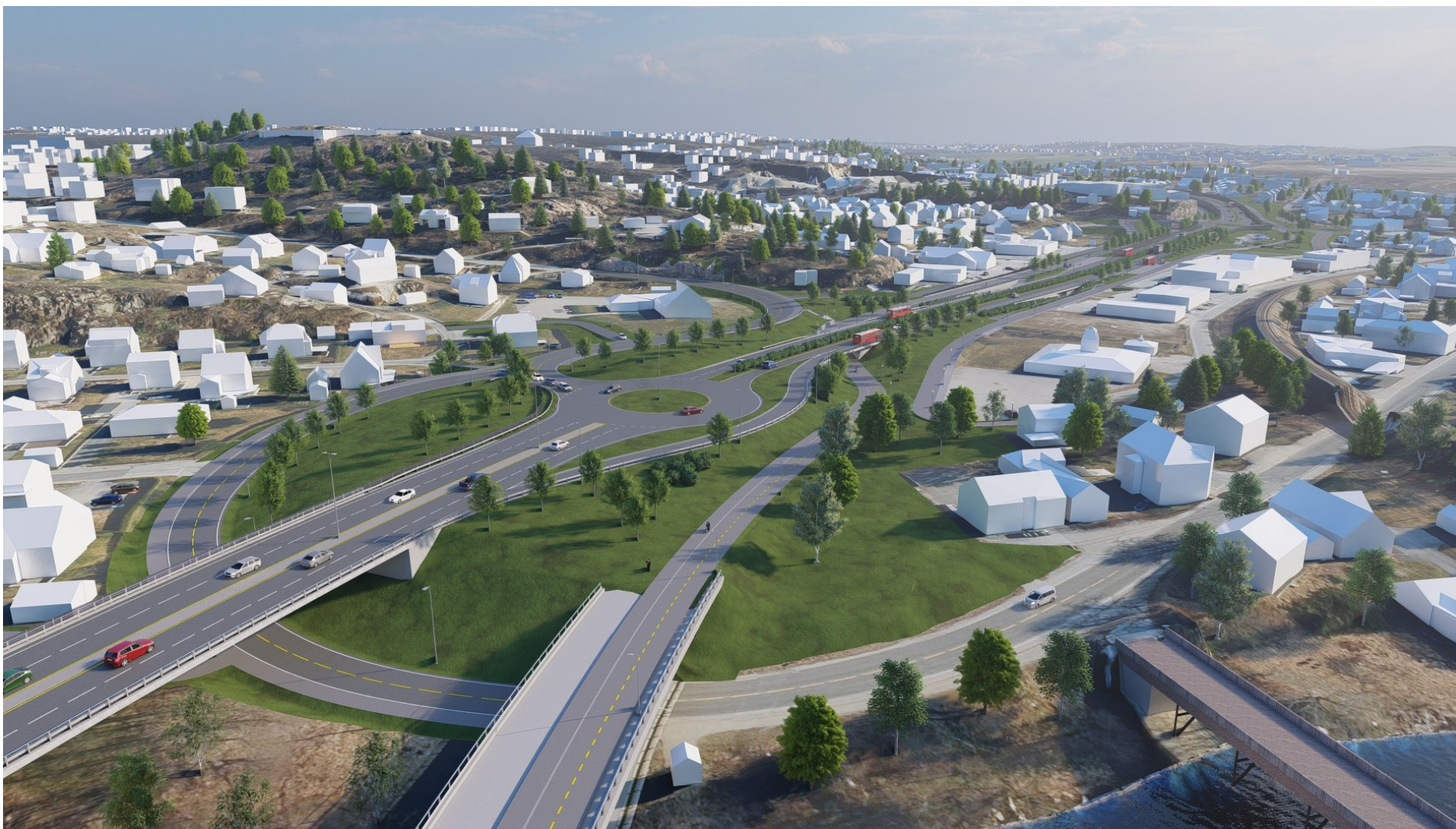
Figur 6-8: Nytt kryss med Opstadveien ligger vest for det gamle og høyere i terrenget. Greåkerveien opprettholdes under bruene. Sykkelveg med fortau kommer inn mot sentrum via den gamle brua og krysser under fylkesvegen rett øst for rundkjøringen som har filterfelt for østgående kollektivtrafikk
