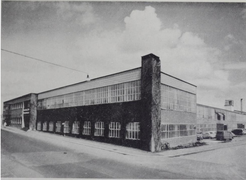
Figur 7-10 Administrasjonsbygget før 1970, sør og deler av østfasaden. Kilde: Hansen 1972: 73.
