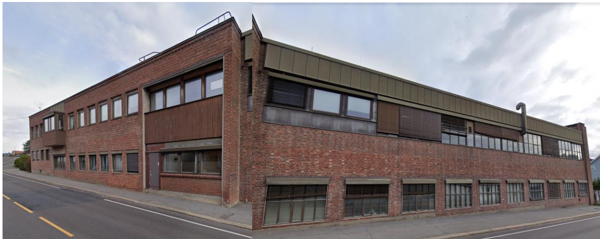
Figur 7-8 Administrasjonsbygget i 2018, sørfasaden. Kilde: Googlestreetview.
