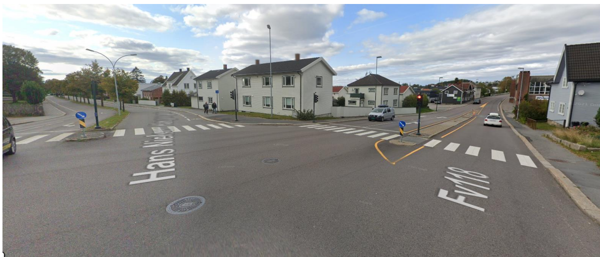
Figur 2-11. Tosidig fortau langs Olav Haraldssons gate vestover og Hans Nielsen Hauges gate sørover fra krysset ved Follogata. Foto: Google StreetView.
