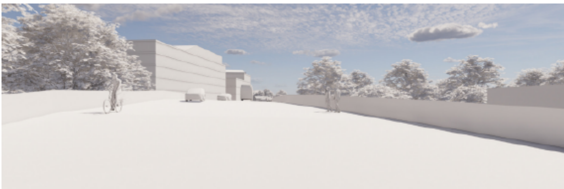
Figur 122 Med tiltak. Fjernvirkning fra Valaskjold bru, sett mot øst.
