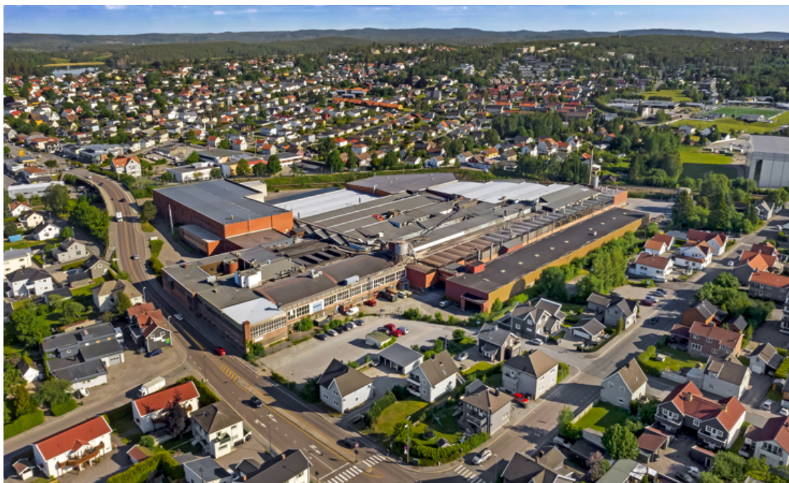
Figur 9 Dagens situasjon. Planområdet sett ovenfra mot nord.
