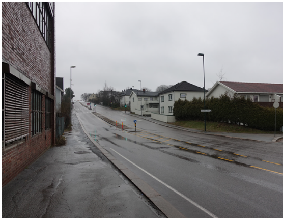
Figur 30 Olav Haraldssons gate fra lavpunktet og sett mot øst. Gatesnittet er dominert av smale fortau, og brede kjørebaneer, tilrettelagt for framkommelighet for store kjøretøy.
