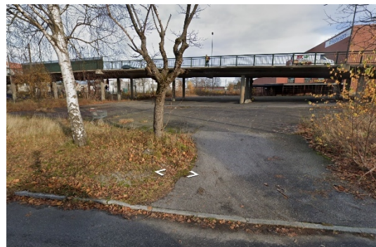
Figur 33 Atkomst fra Olav Haraldssons gate ved Valaskjold bru (C).
