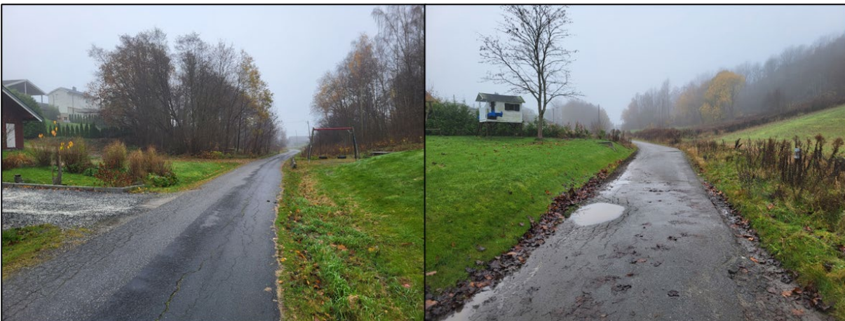
Figur 2-6: Vetabekkveien innenfor analyseområdet. (Kilde: Sweco)
