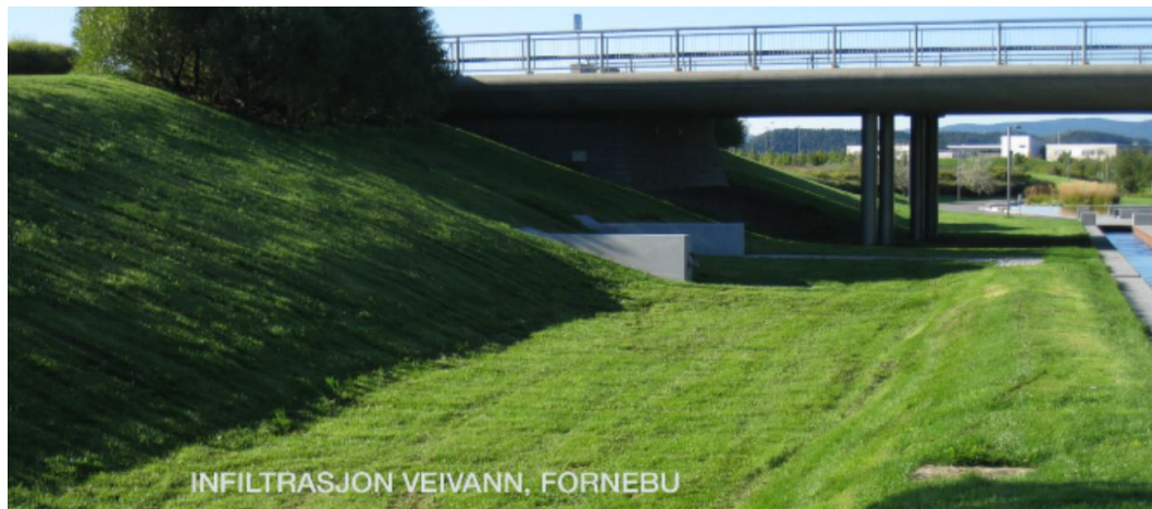
Figur 20. Fordrøyning og infiltrasjon i gresskledd grøfter langs gater og veier. (Kilde: Overvannsveileder for kommunene i vannområdene i Morsa og Glomma sør)
