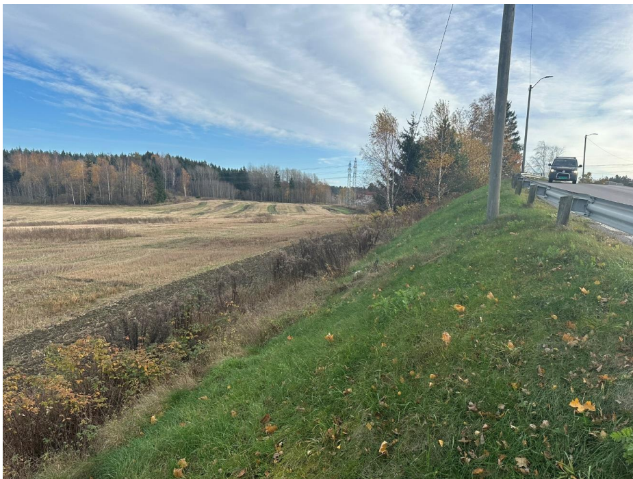
Figur 14-89: Veifylling for dagens Nordbyvei inn mot jernbanekulvert ved Hafslundjordet. Bilde tatt mot sørøst.
