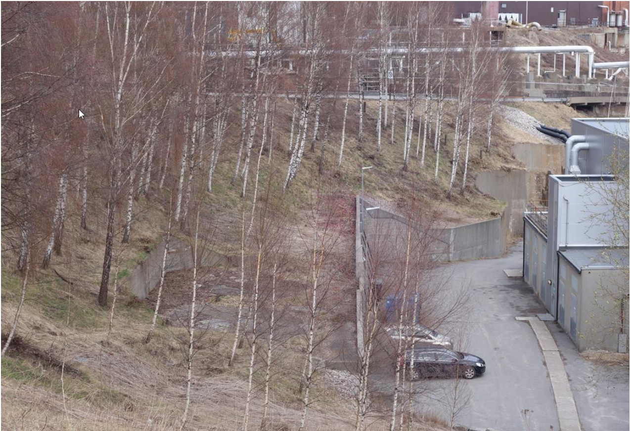
Figur 14-63: Bilde som viser skråningen bak vannverket og eksisterende støttemurer i skråningen.
