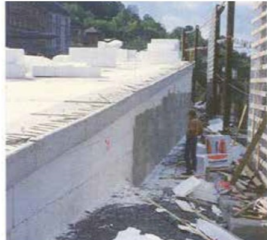
Figur 2-4- 12 Vertikal avslutning av EPS - fylling (Foto: R. Aabøe, Veglaboratoriet)
