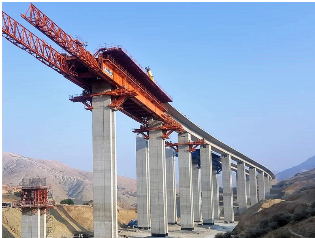
Figur 4-8. Eksempel på bruk av MSS. Hentet fra www.nrsas.com 03.10.2024.
