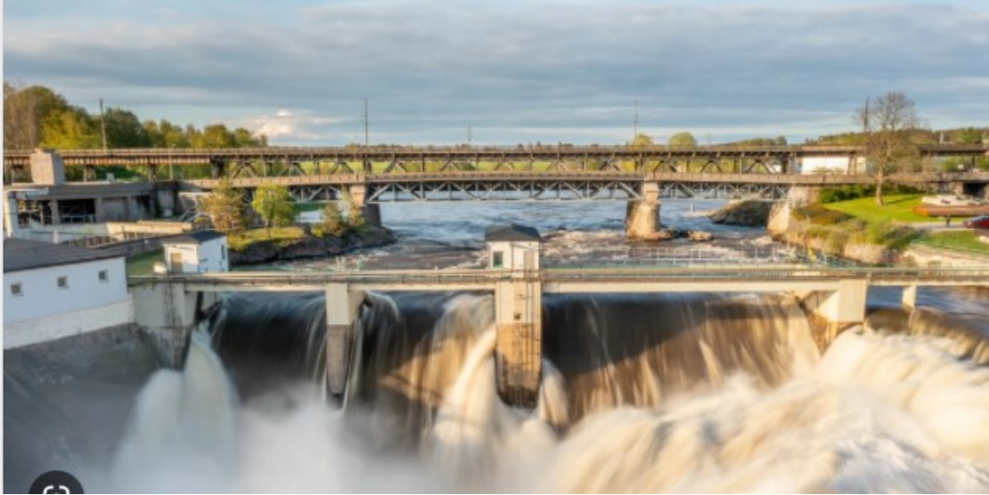
Figur 2-2. Fossen ved kraftverket. Dagens bru og jernbanebru i bakgrunnen. Ny vegbru vil ligge ca. 100m bak jernbanebrua i dette bildet.
