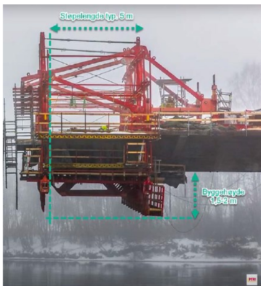
Figur 4-10. Eksempel på forskalingsvogn. Underlagsfoto: Peri Norge AS.
