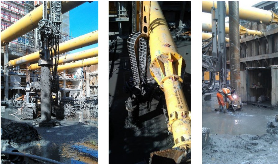
Figur 4-3. Borerigg for installasjon av borede stålørspeler. Bild hentet fra [39].
