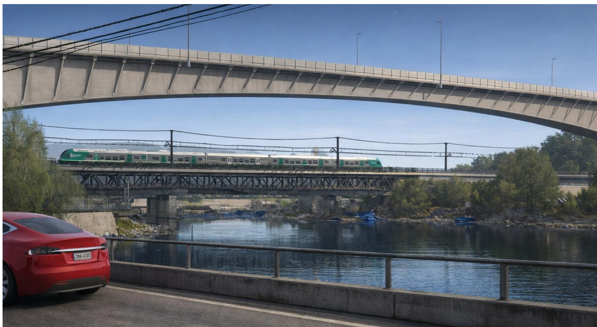
Figur 6-19: Ny bru sett fra mot sørvest fra Grøte bru.
