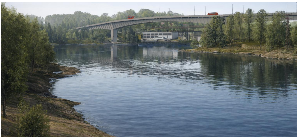
Figur 6-18: Ny bru sett mot sør fra Hafslundsøy.
