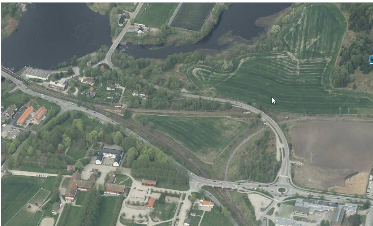
Figur 5-3: Skråfoto som viser strekningen fra Sarpsfossen til Hafslund skole (Sarpsborg kommune).
