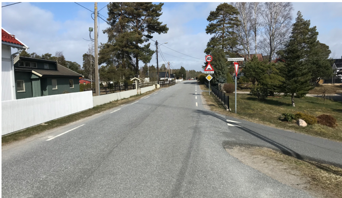
Figur 11: Bilde som viser en del av strekningen. Bildet er tatt ved Kvastebyveien 257 mot nord.
