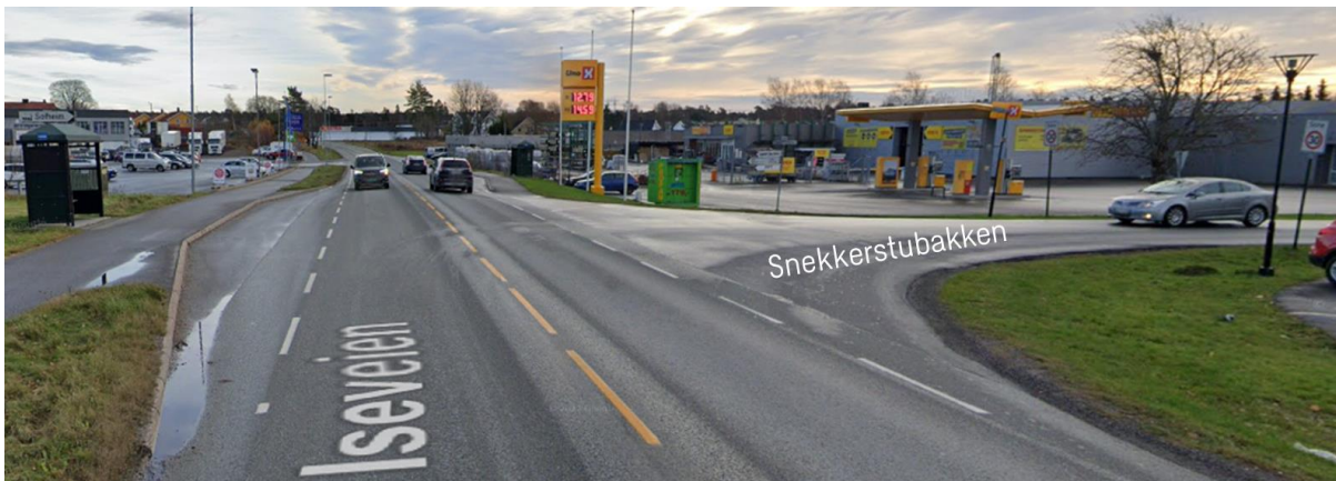
Figur 3: Vikepliktsregulerte T-krysset rv.22 Iseveien X Snekkerstubakken. Sett fra vest for krysset. (Kilde: Google Streetview, nov. 2020)
