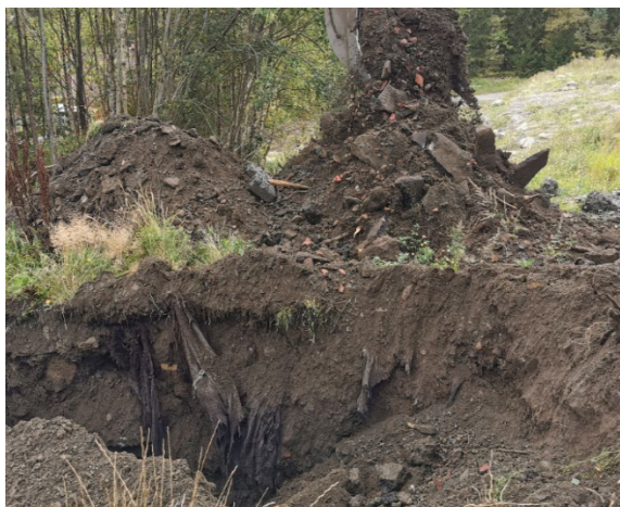
Figur 21: Oppgraving av masser punkt 22
