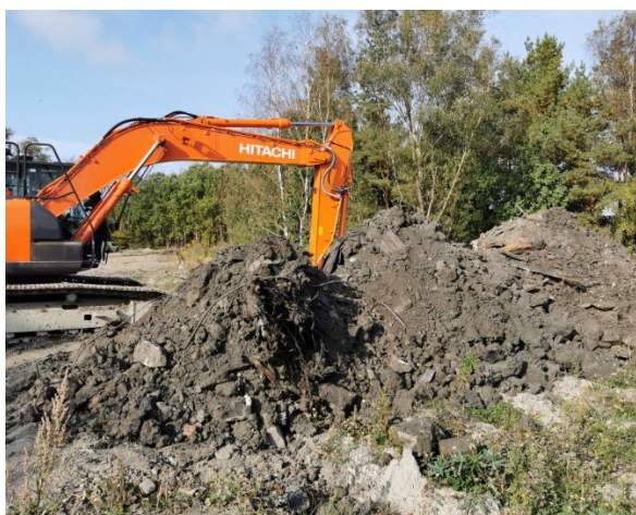
Figur 9: Oppgraving av masser punkt 15
