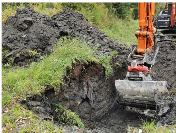
Figur 37: Oppgraving av masser punkt 26
