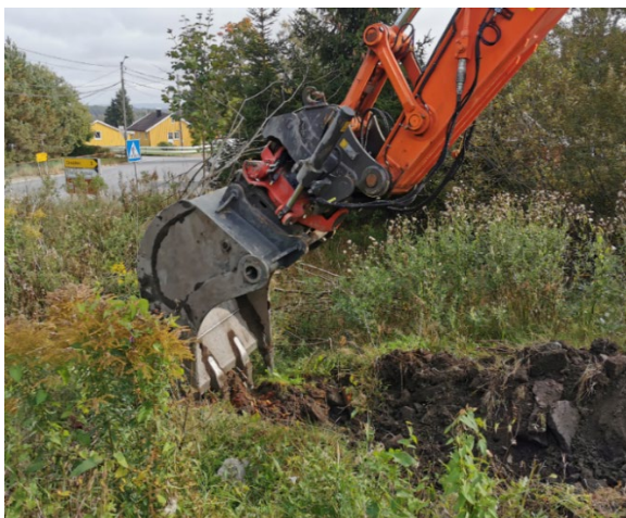
Figur 17: Oppgraving av masser i punkt 21
