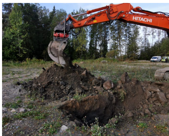
Figur 30: Oppgraving av masser
