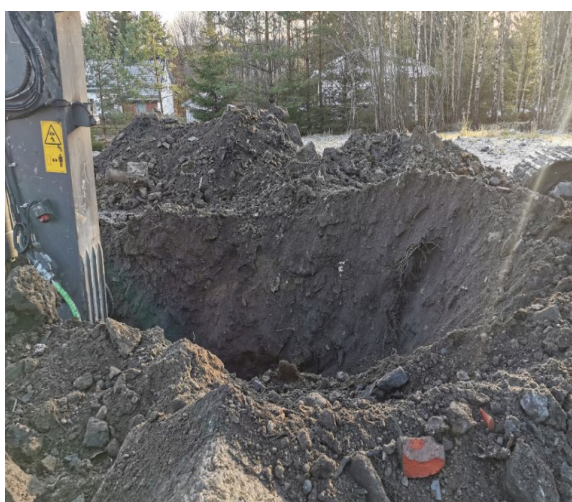
Figur 33 Oppgraving av masser i punkt 2
