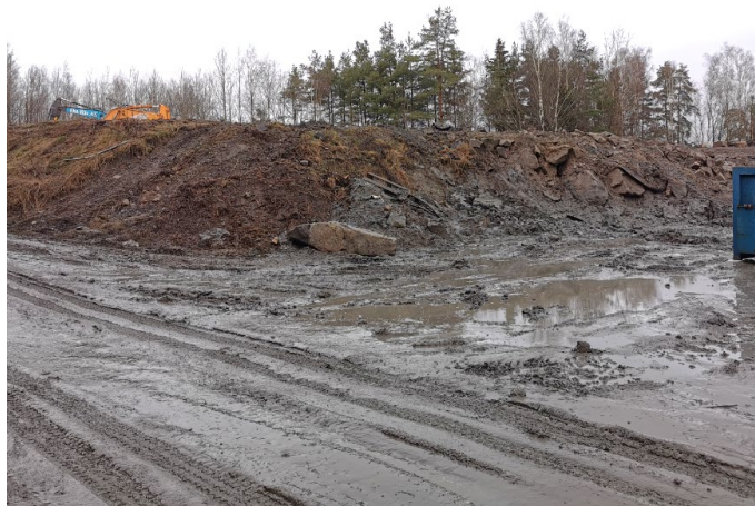
Figur 4 De oppfylte massene strekker seg ca. 2,5 m over terrenget ift. terreng høyden ved innkjøringen.
