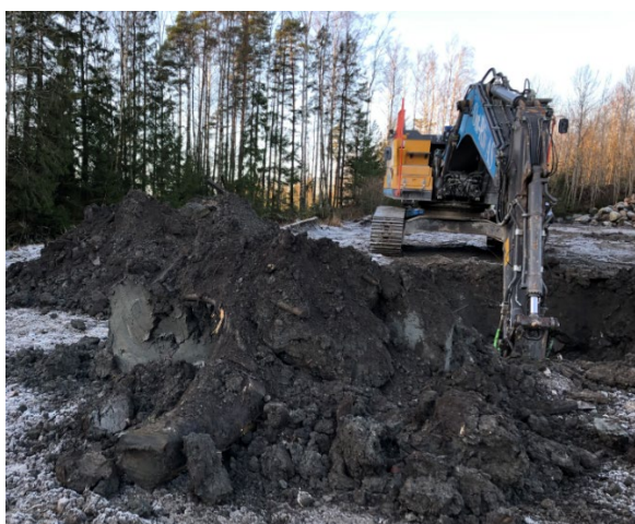
Figur 37 Oppgraving av masser punkt 3
