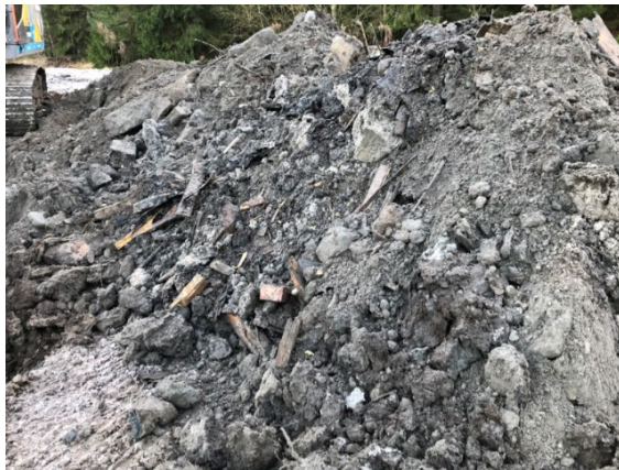
Figur 51 Masser med trevirke
