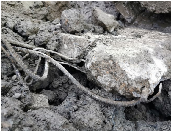
Figur 101 Betong med armering, punkt 8
