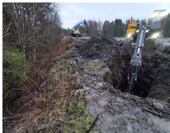
Figur 60 Graving av punkt 8
