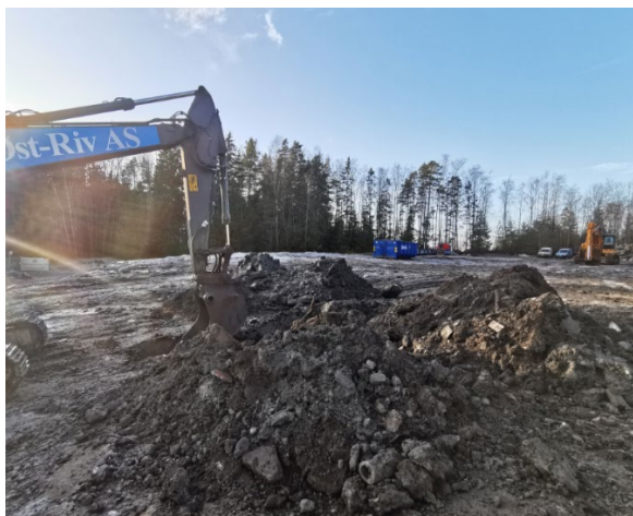
Figur 29 Oppgraving av punkt 1
