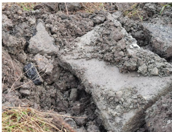
Figur 88 Betong og asfalt i punkt 16
