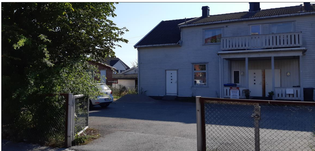
Figur 1.3 – Står i nordøst og tar bilde mot sydvest (Fra befarig 25.08.2022).
