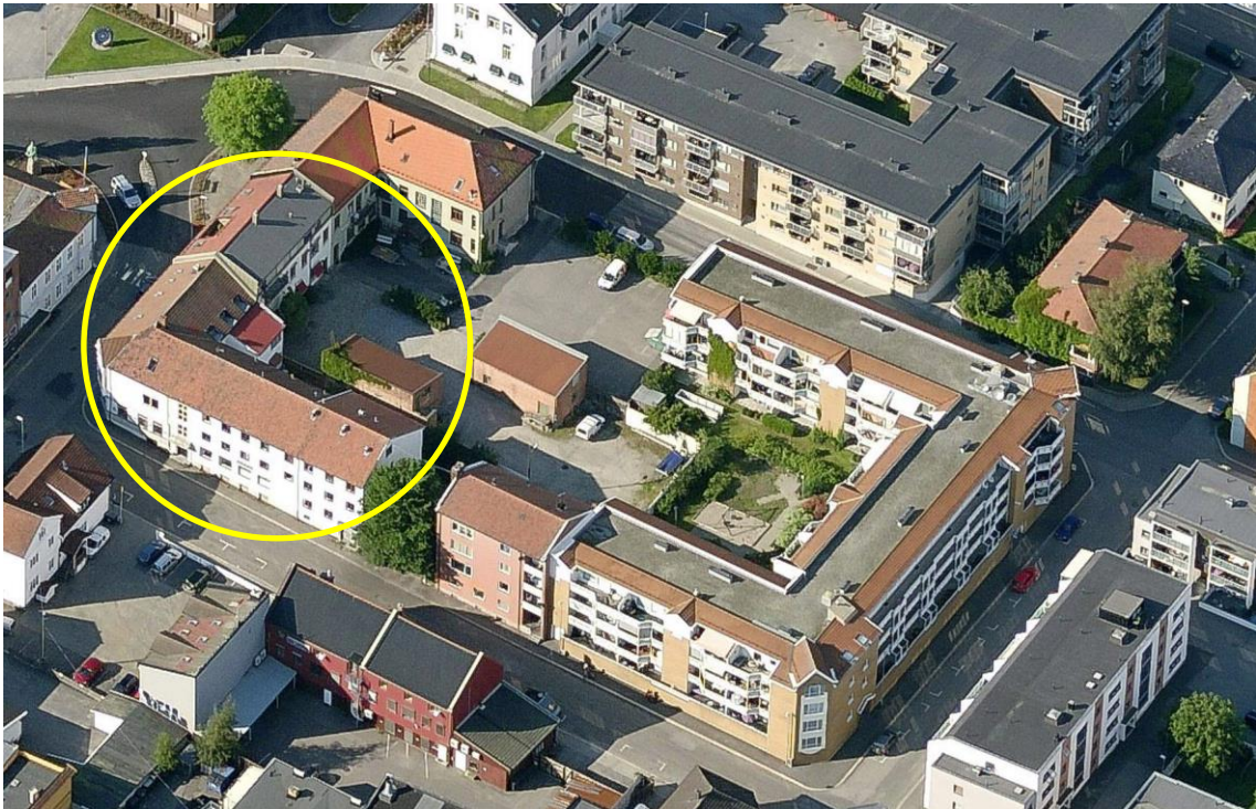
Figur 1 Grandhjørnet ligger i det sørvestre hjørnet på Kvartal 62B i Sarpsborg sentrum. Foto: Google maps.
