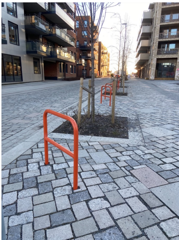
Bilde 2 viser A-stativer i en gate. Stativene er plassert mellom kjørebane og arealer for gående. Foto: Norconsult
