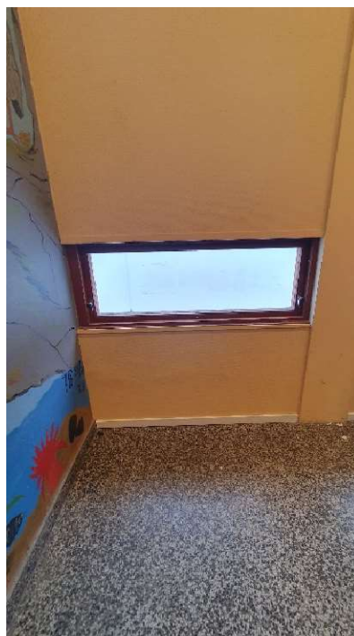
23 Yttervegger. Vinduer i skolebygget fra 1976.
