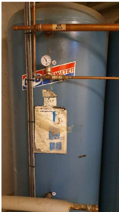
31 Sanitær. Vannbereder fra 1994 byttes
