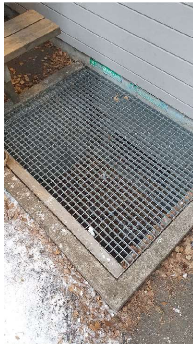
23 Yttervegg. Rømningsvei, bilde tatt fra utside.
