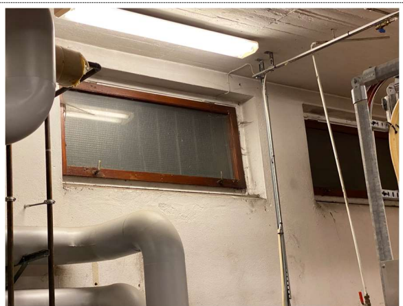
23 Yttervegger. Eldre vinduer fra 1975.
