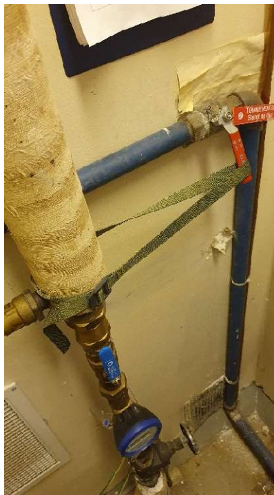
31 Sanitær. Sikring av stoppeventil er ikke tilstedsstillende og isolasjon rundt rør har overskredet levetid.
