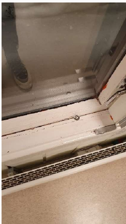
23 Vinduer på kjøkken oppleves som trekkfulle.
