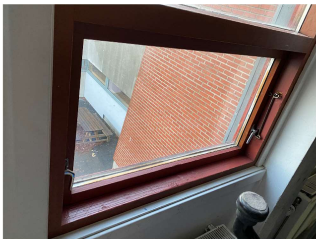
23 Yttervegger. Eldre vinduer.
