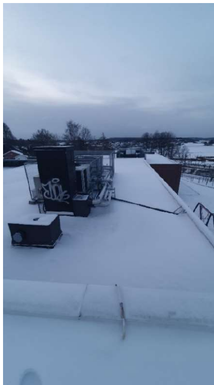
26 Yttertak. Tak der barn klatrer opp.
