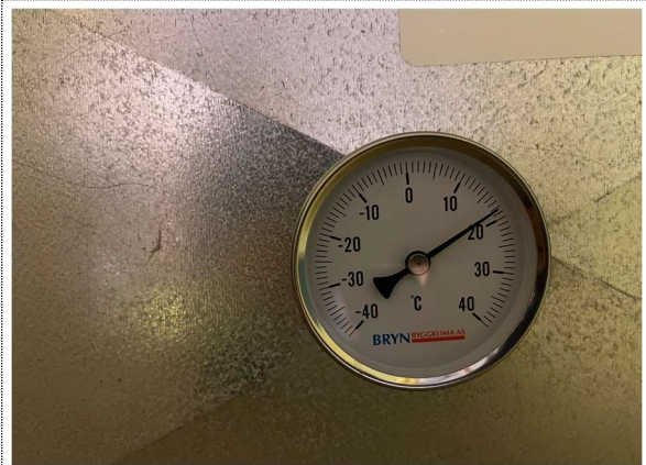
36 Luftbehandling. Behandlet tilluft 18 grader.
