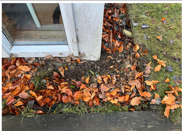
23 Yttervegger. Trepanelet er ført helt ned til bakken, noe som medfører fuktighet og råteskader på materialet.
