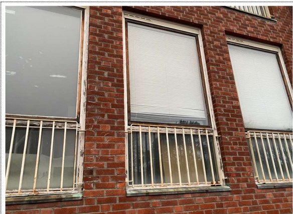
23 Yttervegger. Eldre vinduer fra 1975, bilde tatt utvendig.
