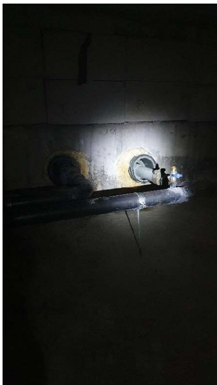
23 Yttervegger. Vann kommer inn under trapp.
