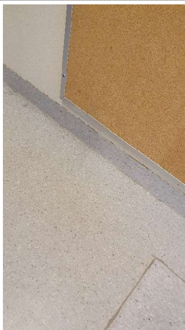
24 Innervegger. Overflater på SFO.
