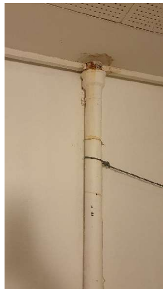
24 Innervegger, vegger rundt basseng
