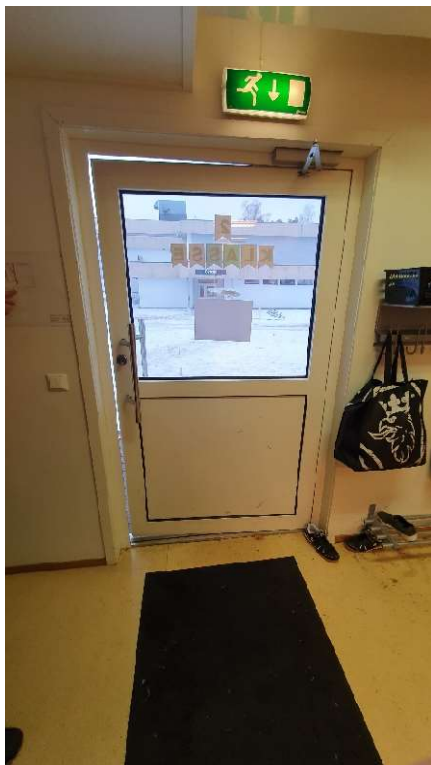
23 Yttervegger. Hoveddør inn til brakkebygg.
