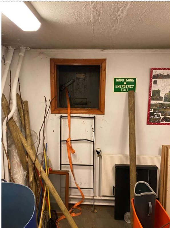
29 Andre bygningsmessige deler. Nødutgang.
