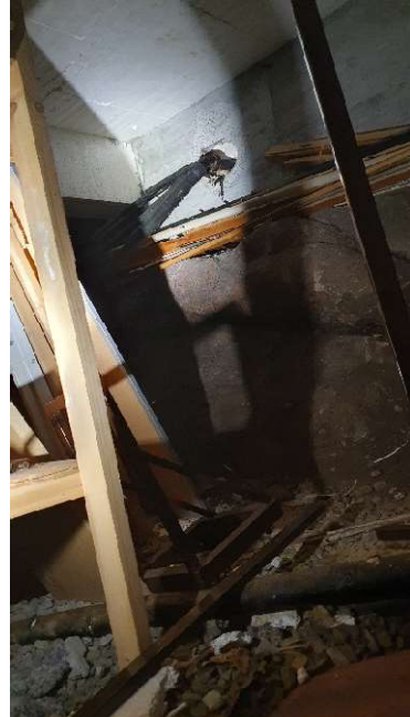
23 Yttervegger. Bilde gjennom utsparing i yttervegg.
