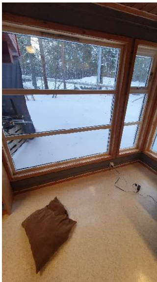
23 Yttervegger. De fleste vinduer i skole er fra 1991.
