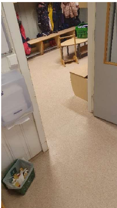
24 Innervegger. Overflater overflatebehandles.
