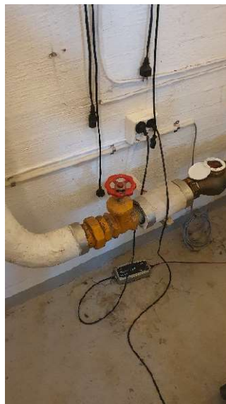
31 Sanitæranlegg, stoppekran
