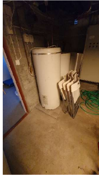
31 Sanitæranlegg, vannbereder.
