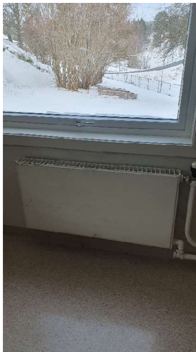
32 Varmeanlegg. Radiatorer byttes
