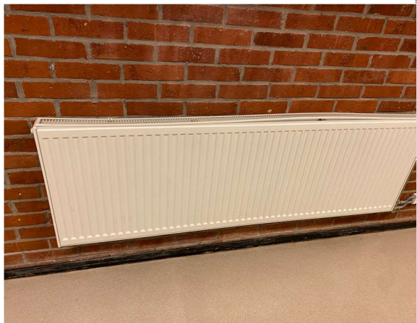
32 Varme. Skadet radiatorer.
