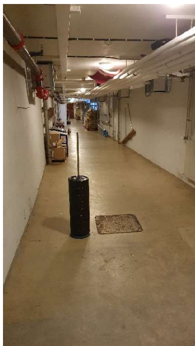
29 Andre bygningsmessige deler. Korridor som er rømningsvei.
