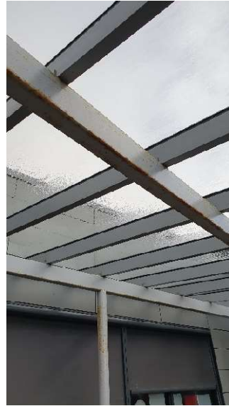
22 Bærende konstruksjoner, stålbejelke og -søyle ved inngangsparti
