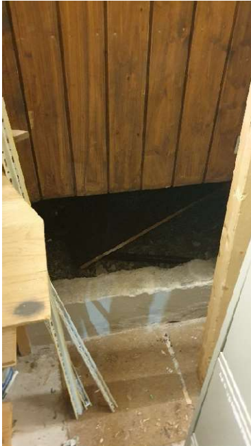
23 Yttervegger. Utsparing i yttervegg mot utside.
