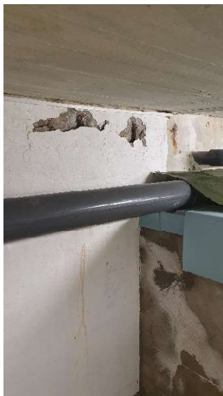
24 Innervegger, vegger rundt basseng
