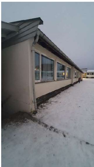
23 Yttervegger, utvendige vinduer. Byttes i 2024
