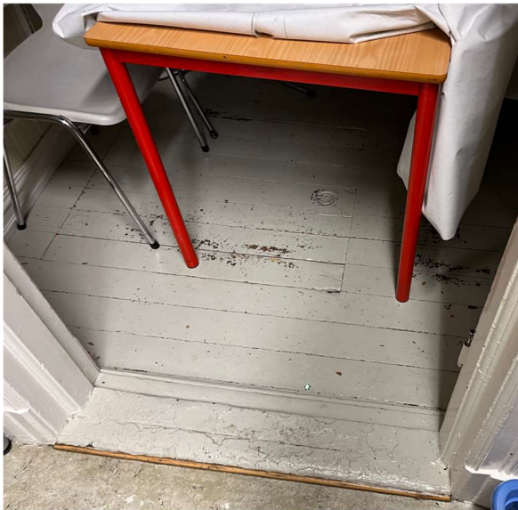
25 Dekker. Fast luke som er ikke mulig å åpne.
