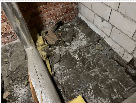
26 Yttertak. Isolasjon på loft ved gymsal.
