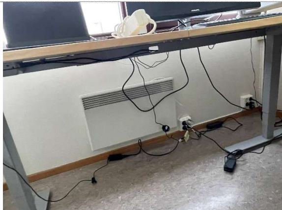
45 Elvarme. Fjern ledninger inntil panelovn.
