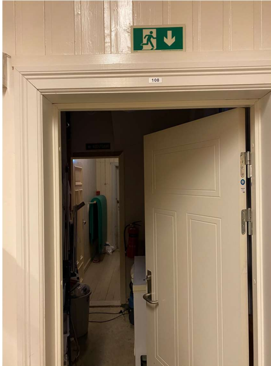
28 Trapper, balkonger m.m. Rotete rømningsveier ved rom 108 og 109.
