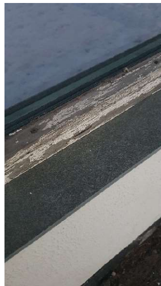
23 Yttervegger, karmer. Byttes i 2024
