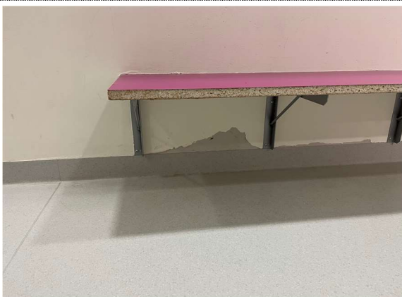
24 Innervegger. Eksempler på skader på belegg og malingen i garderoben.
