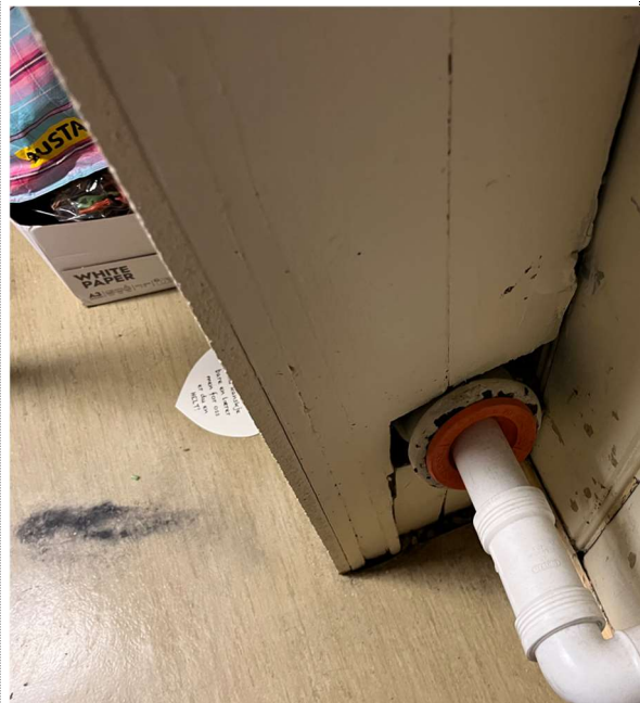
31 Sanitær. Eksempler på eldre sanitærrør.
