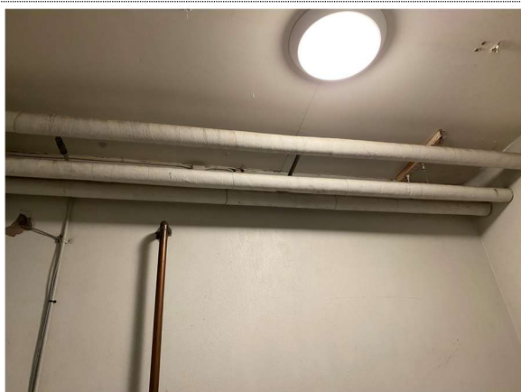
31 Sanitær. Eksempler på eldre sanitærrør.
