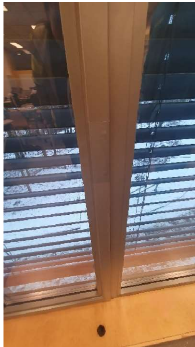
21 Yttervegg. Håndtak fjernet og hull teipet igjen.
