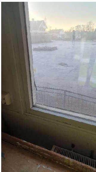
23 Yttervegger i skole
