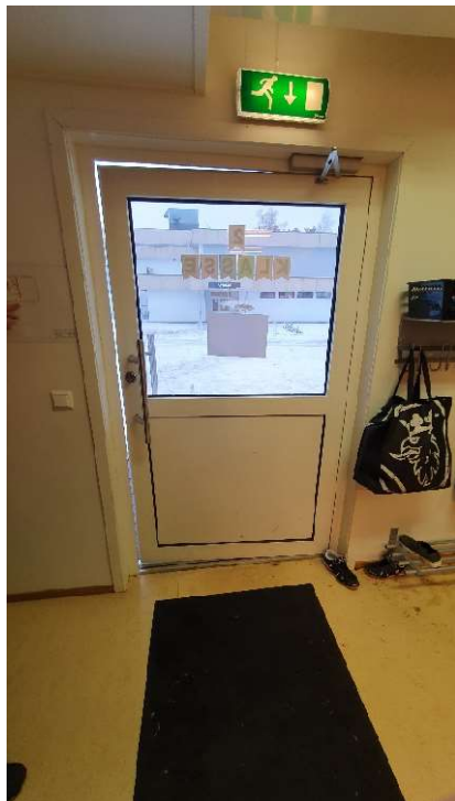
31 Sanitær. Rør i garderob (gymsal).
