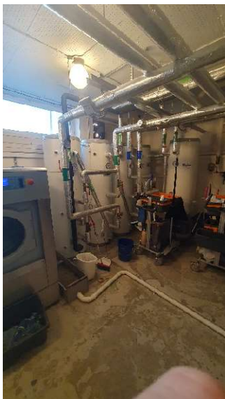
31 Sanitæranlegg, vannberedere
