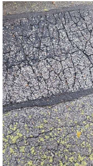
26 Yttertak, takbelegg, nærbilde
