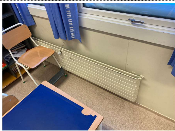
32 Varme. Eksempel på eldre radiatorer i klasserommene.
