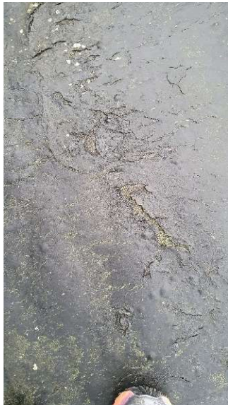
26 Yttertak, nærbilde av tekking
