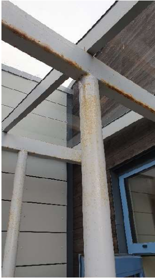
22 Bærende konstruksjoner, stålbejelke og -søyle ved inngangsparti
