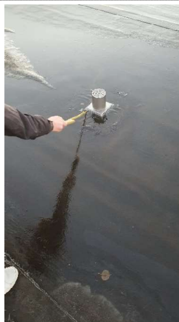
26 Yttertak, tett sluk på tak over ny fløy
