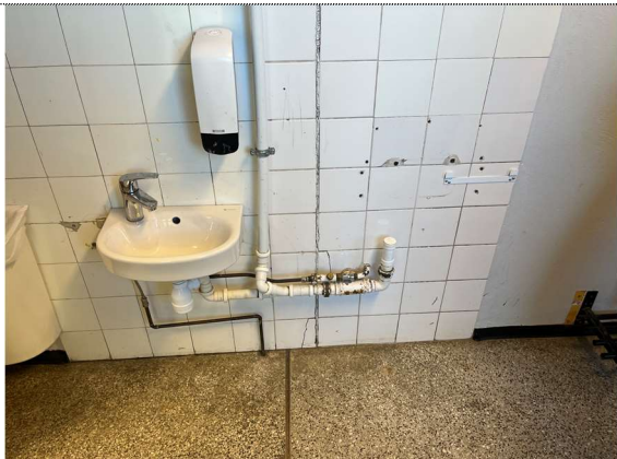
31 Sanitær. Eksempler på eldre sanitærrør.
