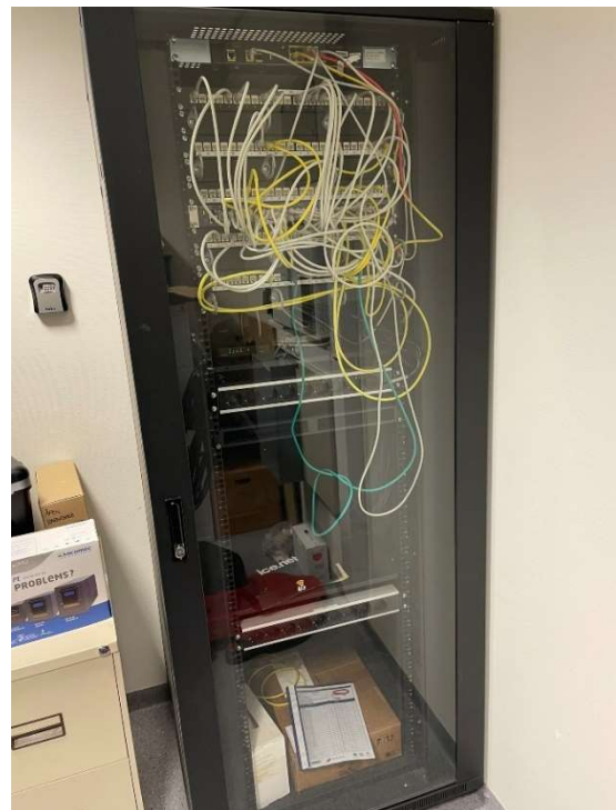
52 Integrert kommunikasjon. Løse ledninger og løse gjenstander foran skap fjernes
