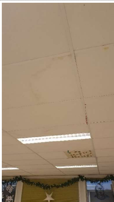
26 Yttertak, himling i SFO
