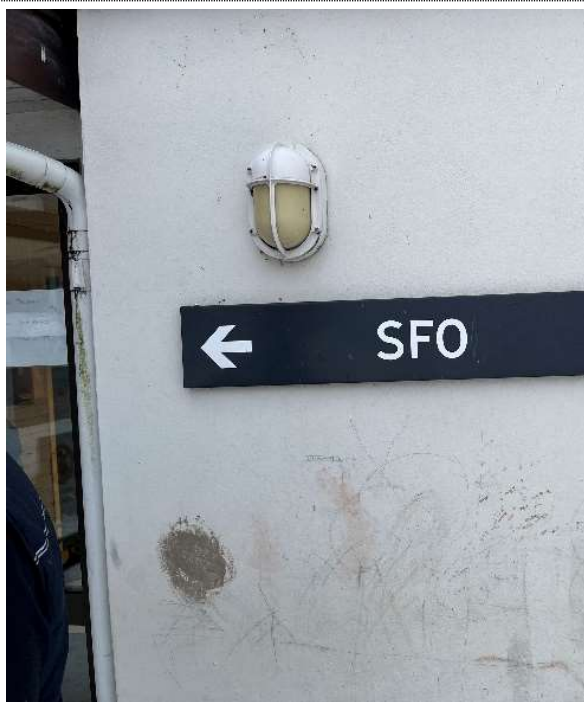
23 Yttervegger. Utvendige overflater på SFO.
