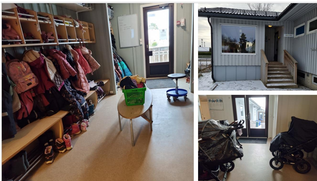
Figur 51 Bildene viser inngangsparti og garderober, som ikke har tilstrekkelig areal til å skille mellom rein og skitten sone. Inngangspartiene med tretrapper er ikke universelt utformet og fremkommelighet i inngangspartier tar ikke hensyn til funksjonsvariasjoner, barns medvirkning og ergonomiske forhold for ansatte og renholder.
