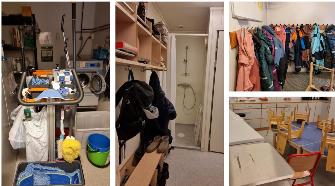
Figur 18 bildene over viser plassmangel i renholdsrom, personalgarderobe med dusjløsning med dusjforheng, og kjøkken som er overmøblert og mangler ganglinjer og sikkerhetssoner mot steke/kokesone. Avfallsbeholder og frittstående fryser tar gulvplass og reduserer fremkommelighet ytterligere.
