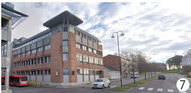
Korsgata 5, kontorbygg ca. 1990. Bygget er i dag uegnet som kontor bla på grunn av etasjehøyder og nivåforskjeller
