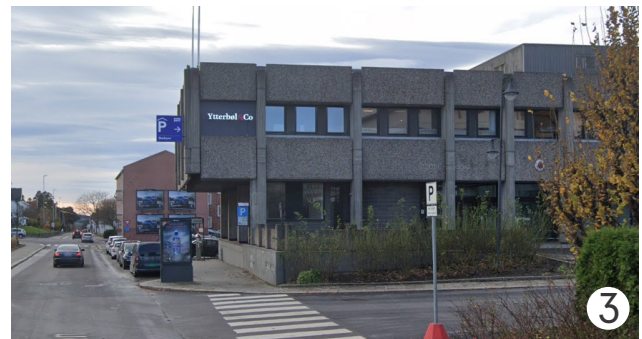
Sandesundsveien 3b, kontorbygg fra ca. 1970, betong
