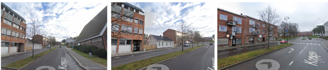
Sett fra vest/Korsgata, kirken er ikke synlig i dag
