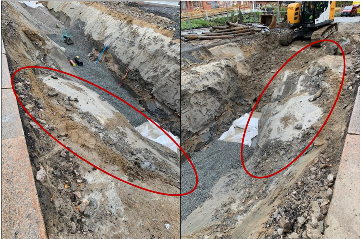
Figur 9: Bildedokumentasjon på at det er Fjell under kirken
