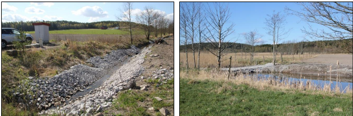
Figur 18. Skjørenbekken oppstrøms fangdammen (bilde til venstre). Pumpestasjonen på bilde er kommunal og pumper kloakk fra eiendommene på Skjørenlandet videre til rensesanlegget på Alvim.
